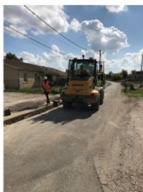
Zone de travaux
