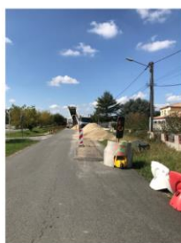
Zone de travaux
