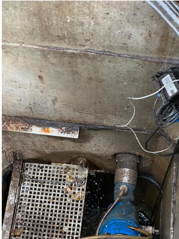
Bâche de transfert – Chemin de la Messe
